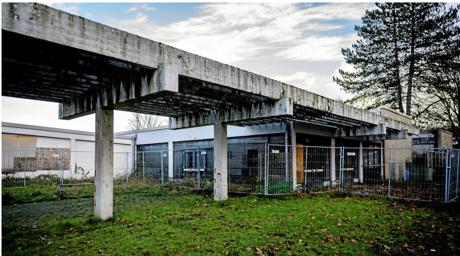
In diese ehemalige Schule sollte das Marler Skulpturenmuseum einziehen (Marschall 66). Doch der Stadtrat verweigerte sieben Millionen Euro für gestiegene Baukosten. Jetzt steht das ganze Projekt auf der Kippe, ein Neubaugebiet in der Nähe gleich mit. RALF ROTTMANN FFS
